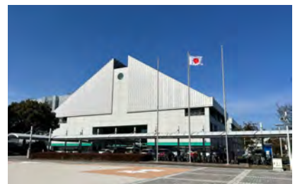
▲総合体育館改修事業
