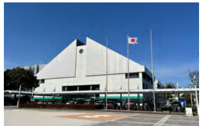
▲ 総合体育館改修事業
