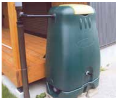
雨水貯留タンク
