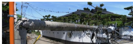
ライフライン被害
