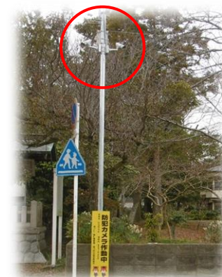
防犯カメラ(設置例)
