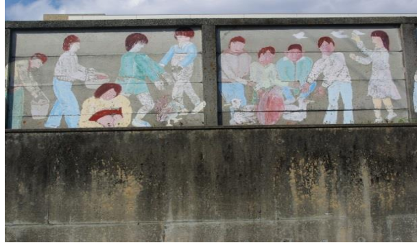
がいへき 第5回卒業生 プール外壁南部分
