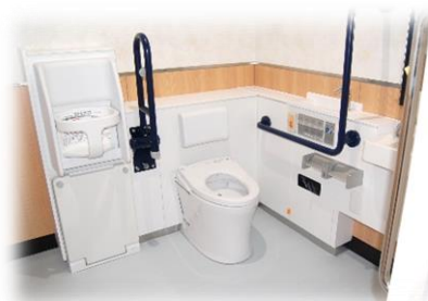
体育館トイレ「みんなのトイレ」完成
